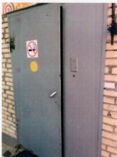
Дверь центрального входа «До»
