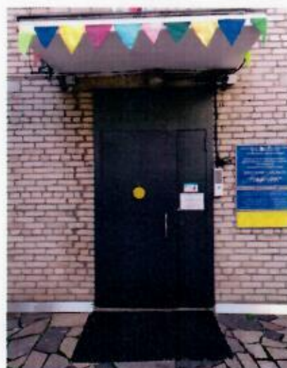
Дверь центрального входа «После»
