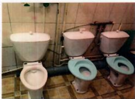
Оборудование санузлов «До»
